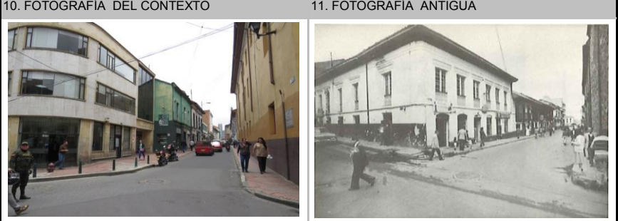
Fuente: Equipo Fotografía PEMP Patrimonio Inmueble Fuente: Recorridos fotográficos por el centro de Bogotá, Noviembre 1981 - Febrero 1982, Colcultura
